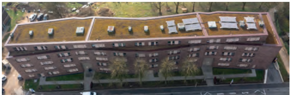
Un exemple de toiture verte et panneaux solaires, rue de Mühlentbach à Luxembourg-Ville. Photo-Photothèque de la Ville de Luxembourg
